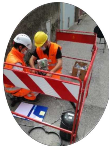
I nostri tecnici mentre giungano il cavo in fibra ottica per portarlo in casa
