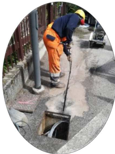
I nostri tecnici impegnati in uno scavo in tecnica di microtrincea
