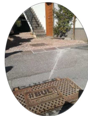
Esempio di scavo su proprietà pubblica e collegamento ad infrastruttura del privato
